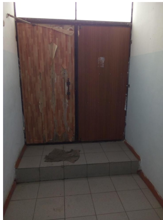
Фото № 4 Дверь (входная)
