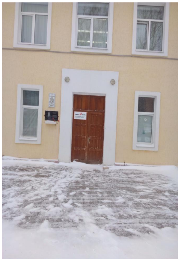
Фото № 3 Входная площадка (перед дверью)
